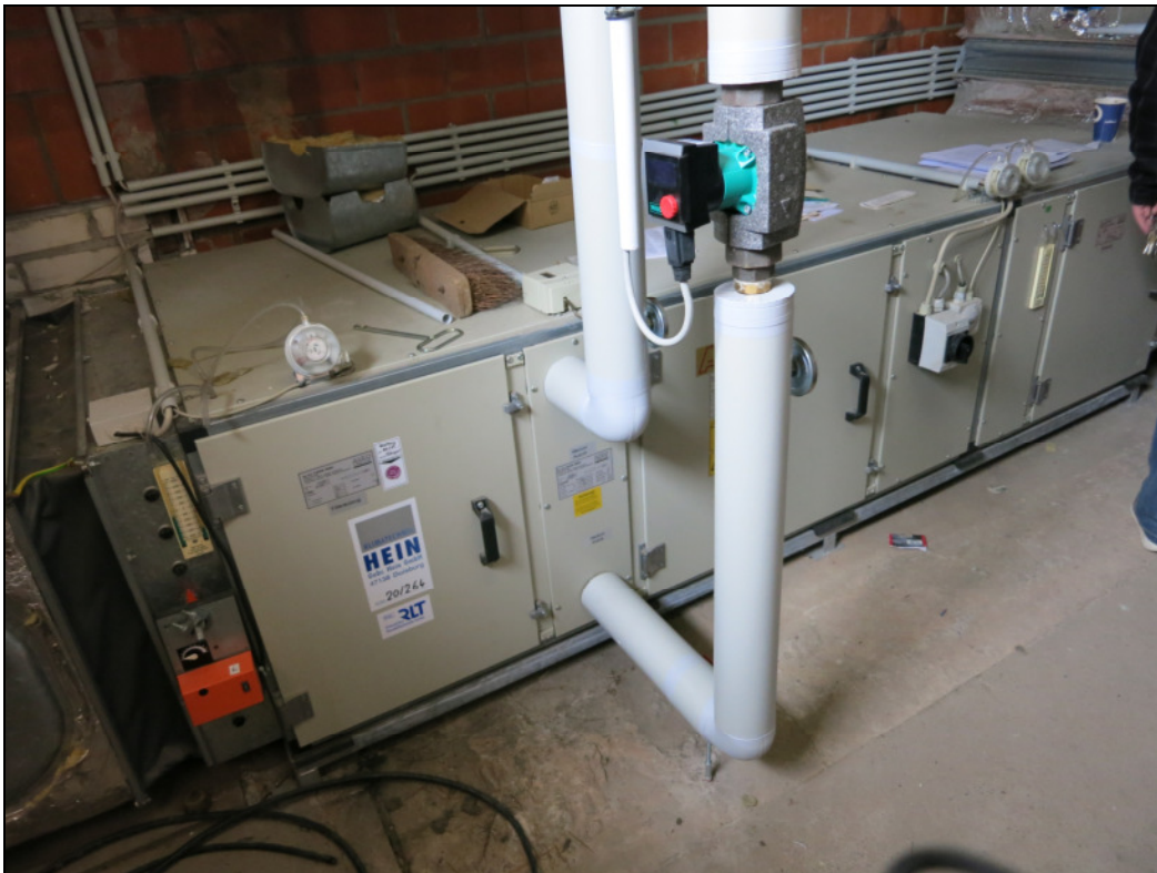
Bild 8: Lüftungsanlage Hallenbeheizung
