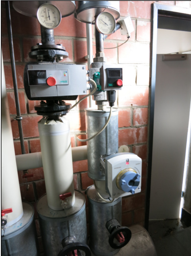
Bild 7: Verteileranlage Heizungseinspeisung mit Umwälzpumpen
