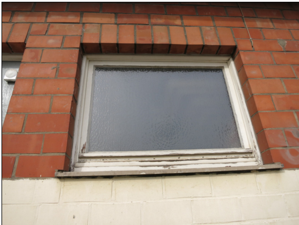
Bild 14: Schwachstelle: altes Holzrahmen-Fenster
